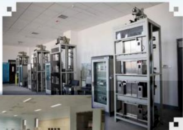
智能电梯安装调试 维护训练场所
